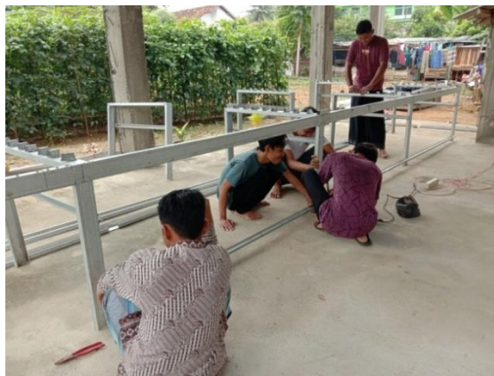
Gambar 2. Pemasangan Instalasi yang dilakukan Tim dan Santri
