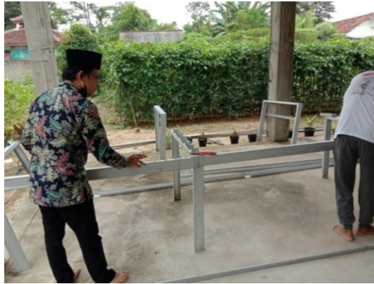
Gambar 1. Proses Pemasangan Instalasi
