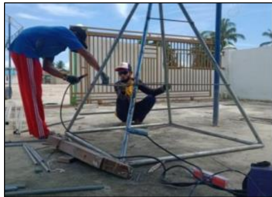
Gambar 7. Pemasangan penguat rangka
