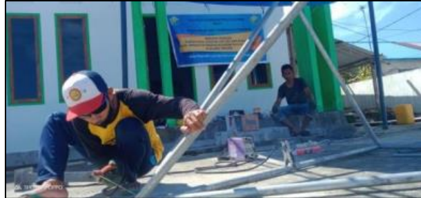
Gambar 6. Pemasangan rangka utama
