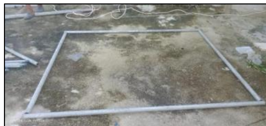
Gambar 5. Rangka utama atau rangka dasar
